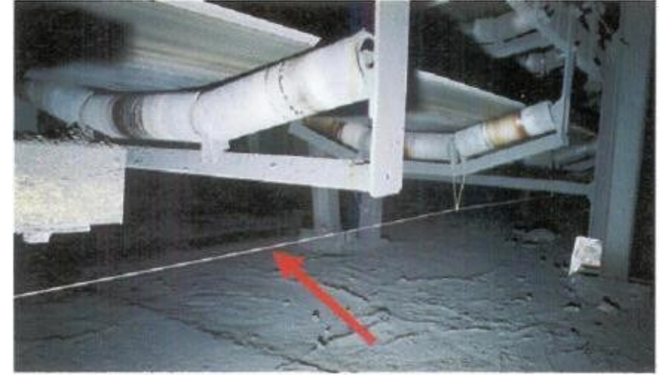
Lắp đặt sợi cảm biến quang
